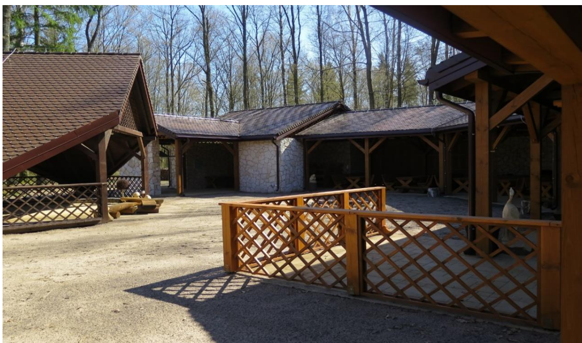
Fot. 6. Wiata turystyczna „Koryciny”
